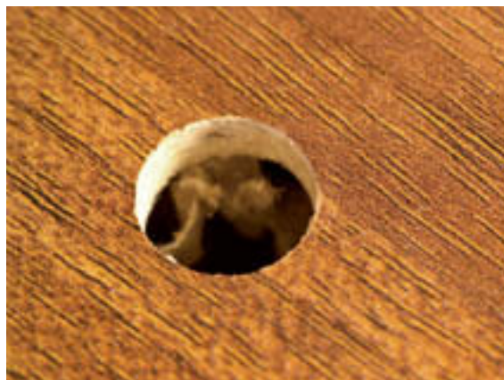
2. De boring reinigen
