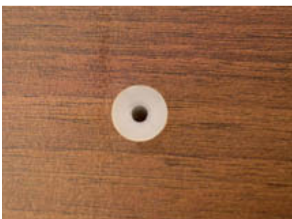
5. Aan de kleurverandering kan het einde van het injectieproces worden herkend
